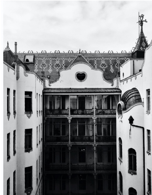
Az épület belső udvara a helyreállítás előtt
